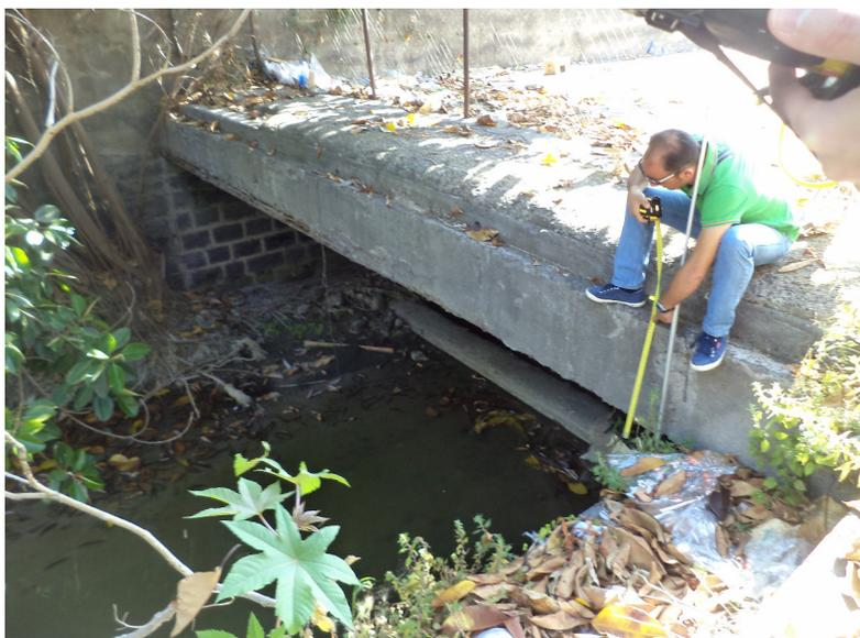
E.12.1 - Tr. n. 12 (tombino fra il cimitero e la ferrovia). Sezione d'imbocco Ti,. Si noti la piccola soglia circa 1 m a valle della sezione d'imbocco
