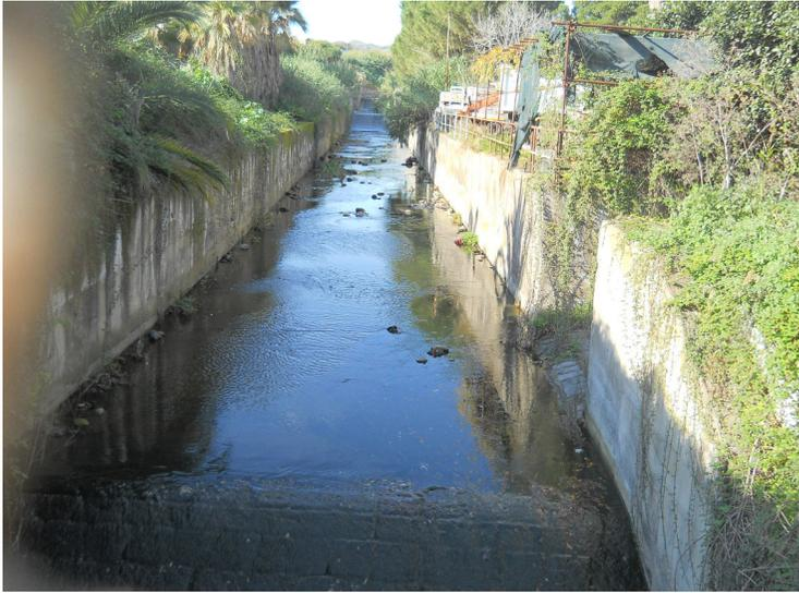
E.9.2 - Tr. n. 9. Tratto a monte del ponticello P12 (via Ungaretti), vista verso monte. Si nota in primo piano la testa dello scivolo e a destra l'interruzione del muro di sponda per la discenderia
