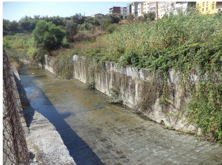
E.11.4 - Tr. n. 11. Tratto a valle del ponte P9. Sovralzo del muro di sponda sinistra
