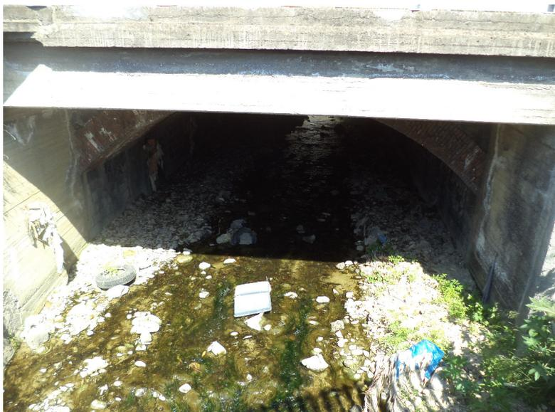
E.14.4 - Tr. n. 14. Ponte ferroviario P7. Si nota come il ponte originario, ad arco ribassato in mattoni e spalle in muratura di pietrame, è stato ampliato verso valle affiancandovi un ponte in cemento armato
