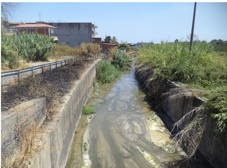
E.10.3 - Tr. n. 10. Vista come le foto precedenti, in presenza di vegetazione la testa dello scivolo e a destra l'interruzione del muro di sponda per la discenderia
