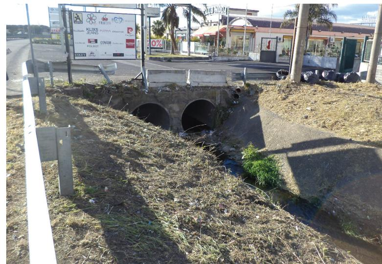
B.2.4 - Tronco 2c, sezione terminale VA1, due tubi DN 1400
