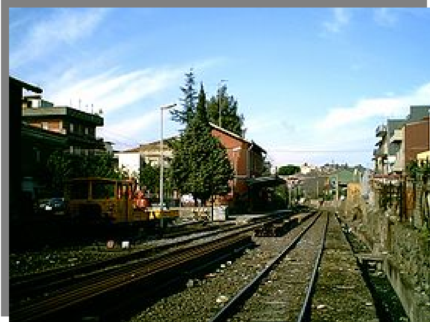
Figura 13- Stazione di Misterbianco della Ferrovia Circumetnea
